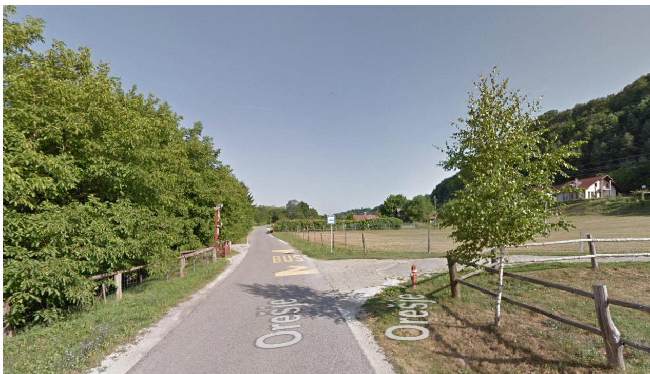
Nevarni odsek brez pločnika – Orešje
