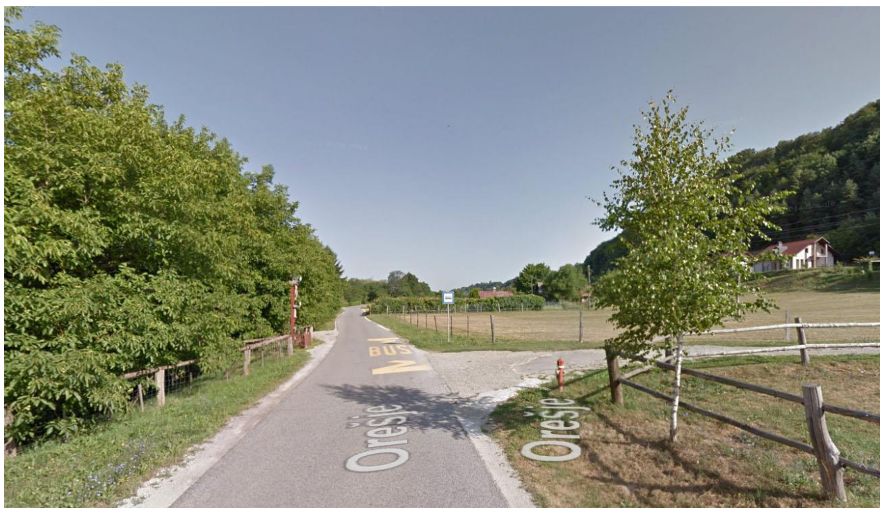
Nevarni odsek brez pločnika – Orešje
